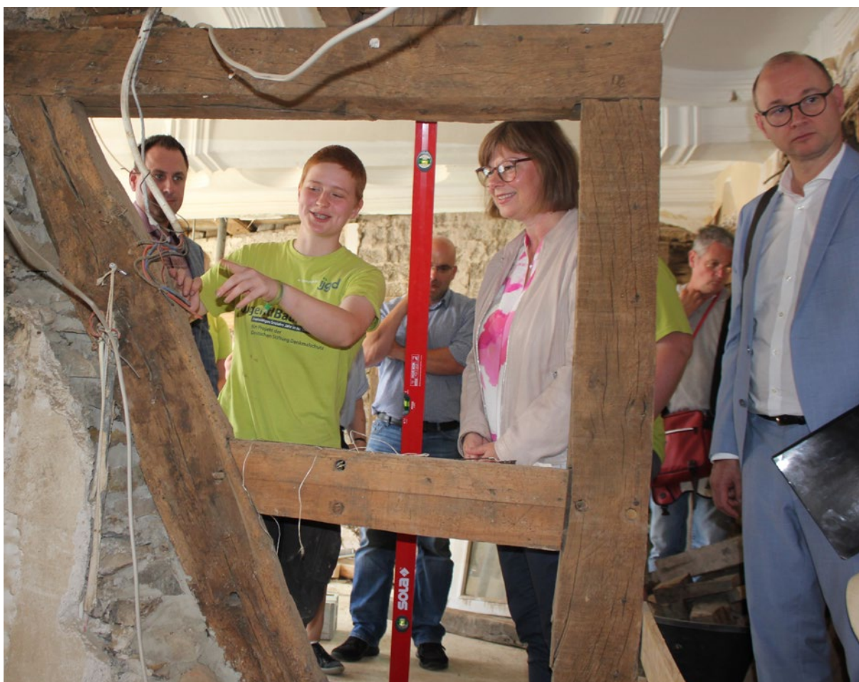
Besuch der Wiederaufbaubeauftragten Nicole Steingaß eines Projektes zum Wiederaufbau eines jüdischen Gebetshauses in Dernau.
